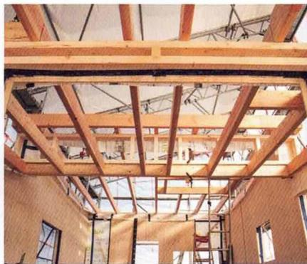
Das Ständerwerk wird von Zimmerleuten aus Fichtenholz errichtet. Es wird in Segmenten gebaut und dann zusammengefügt.
